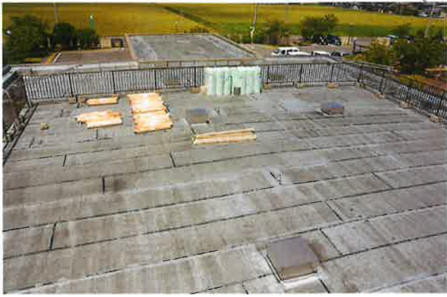
屋上 防水工事 工事前
